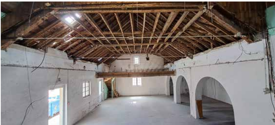
Salle des fêtes : démolition de l'intérieur
